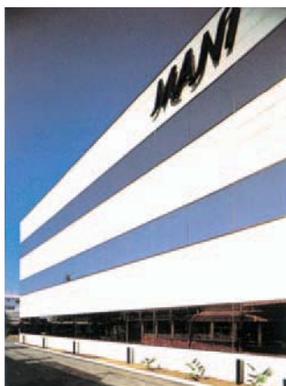
▲マニー(株) 高根沢工場 MANI TAKANEZAWA Facility
